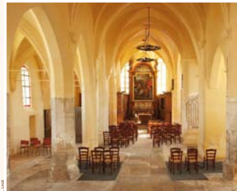
La nef centrale se développe sur 5 travées et le transept près du chœur, sur 2 travées. Les voûtes sont portées par des colonnes polygonales. Le décor sculpté, de style Renaissance, est dépouillé.
